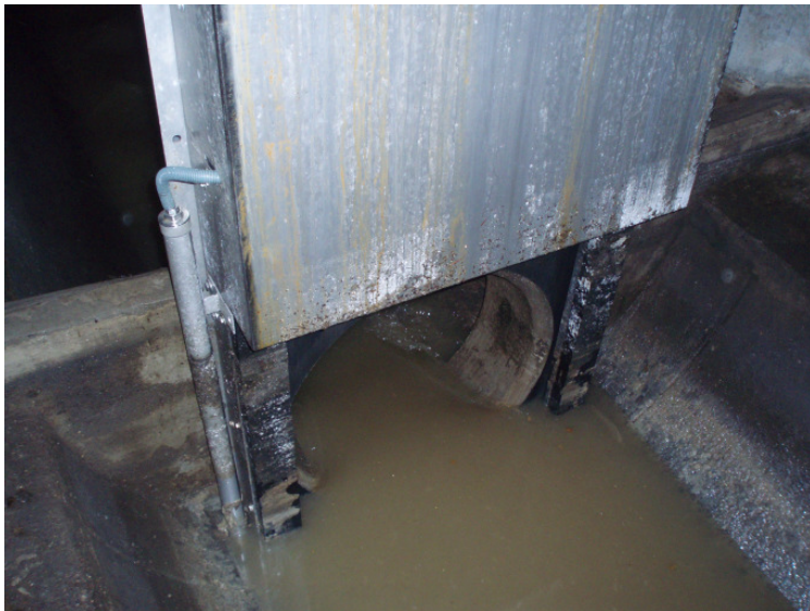
Bild 1 u. 2: Stauraumkanal ohne Spülung (Spülung für 5 Tage deaktiviert)
