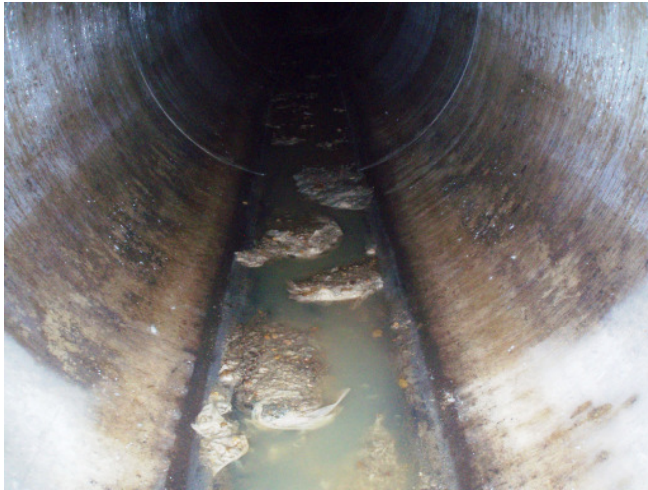
Bild 1 u. 2: Stauraumkanal ohne Spülung (Spülung für 5 Tage deaktiviert)
