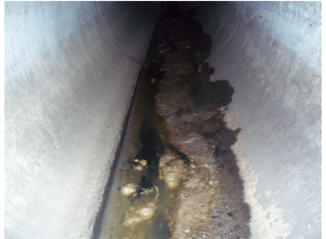
Bild 1 u. 2: Stauraumkanal ohne Spülung (Spülung für 5 Tage deaktiviert)
